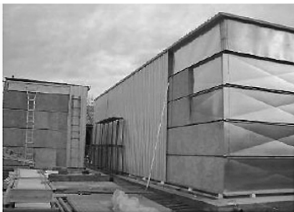
Montáž sušárny, hliníkové kazety s izolací
